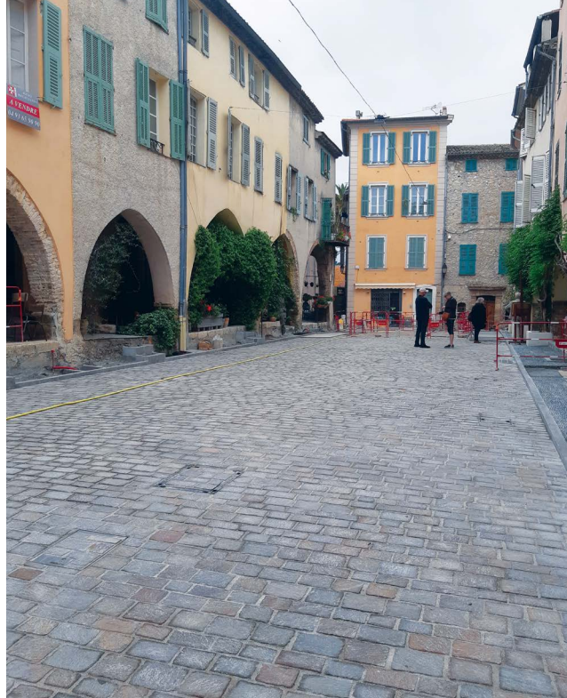
Une place des Arcades rénovée
