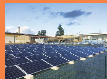
Installations de panneaux photovoltaïques
